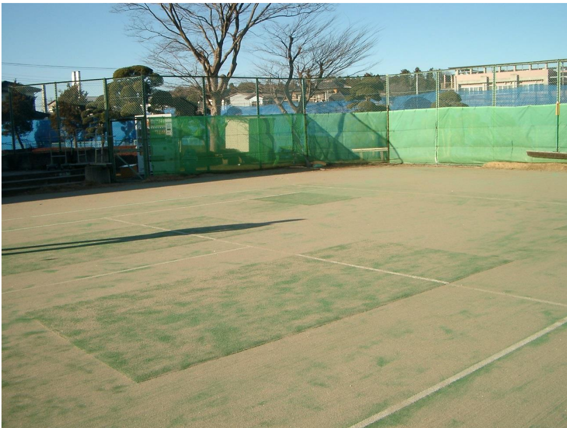
別添-1 現在の部分補修状況
