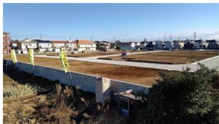
鎌ヶ谷9丁目大規模造成。盛り土擁壁の圧迫感甚大
